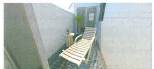
敷地を有効活用するグレーチングバルコニー
